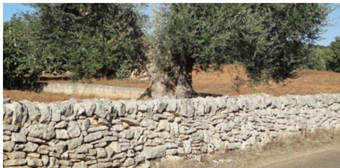
Muretto a secco Foto di repertorio da Internet
