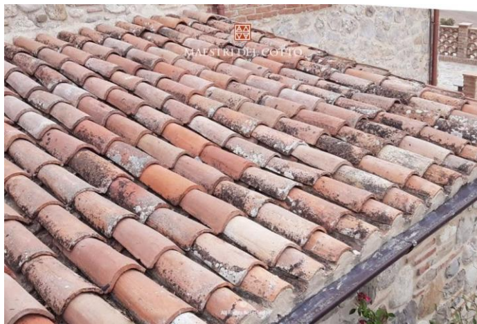
Copertura tetto con 'pingele' Foto di repertorio da Internet
